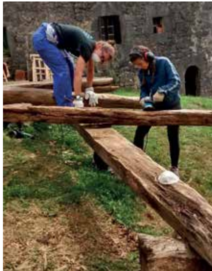
Ezkerrean: Egur zaharren garbiketa, tresna ezberdinak probatzen. Arg: Irati Ezeiza. Behean: Txoritokiaren teiltua eraikitzen. Arg: Yakov Olevsky.
